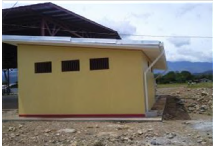
Bateria de baños y servicios sanitarios
