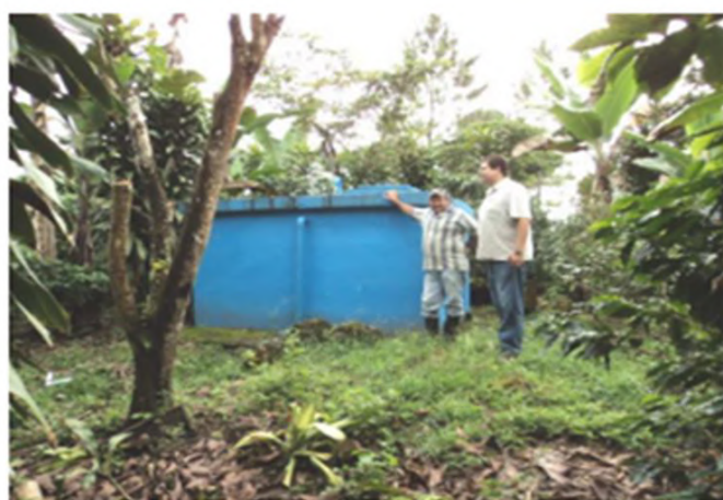
Acueducto San Marcos y Brasilia
