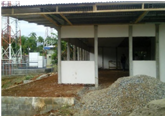
Construcción de centro de computo
