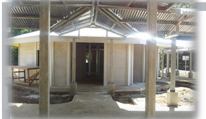
Instalaciones EBAIS La Casona
